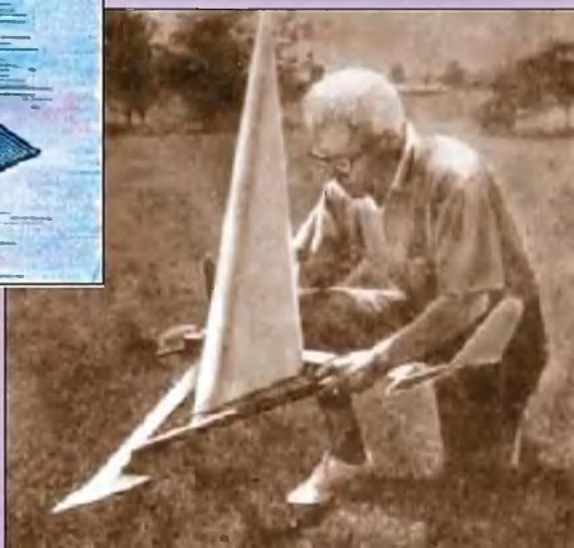
Примечательно, что оба крыла расположены по одну сторону от балки. На ней расположена поворотная мачта-крыло, к которой крепится мягкий парус. Сбоку на шарнирно закрепленной балке установлено еще одно подводное крыло, служащее для сохранения устойчивости при боковом ветре. Управление аппаратом производится при помощи воздушного руля и стабилизатора, как на самолете.
